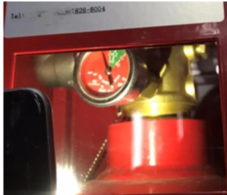
Abbildung 9: Kontrollfenster mit Manometer.
